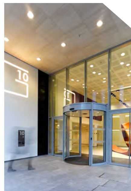
Kantoorgebouw Guimard 10-12 Brussel Leopoldwijk (BE)
